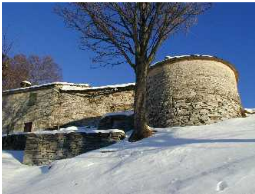
Fig. 1 : La nevèra (à droite) est un bâtiment de forme cylindrique, enterré pour les deux tiers, avec un toit conique en pierre. Fort présents sur les alpages du Monte Generoso, les nevère caractérisent le paysage rural. Dans cette région karstique, l'eau de source est rare et l'élément réfrigérateur est la neige.
